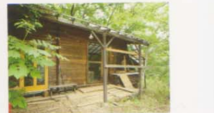
都留市に移住して最初に建てたログハウス。スギと廃材を使ったセルフビルドで、いまはゲストハウスとして使用している
